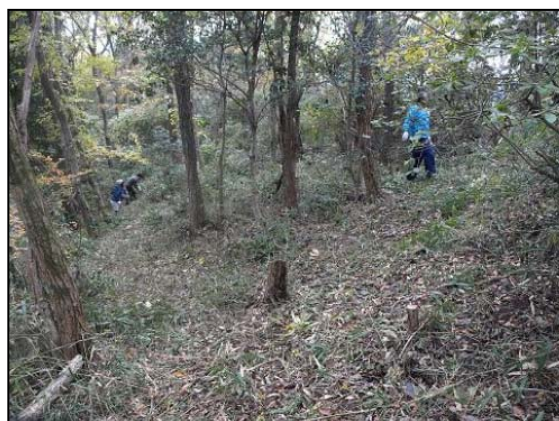
西側林道と中央部北側林内とを 結ぶ作業用連絡通路完成！
