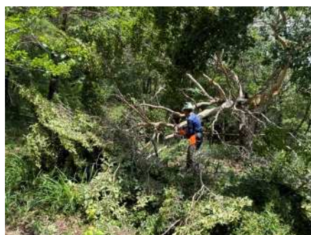
展望台広場 倒木処理作業中
