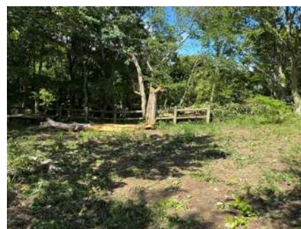
展望台広場 倒木処理作業後
