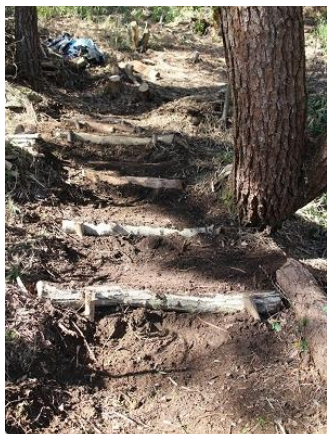
完成した作業道階段
