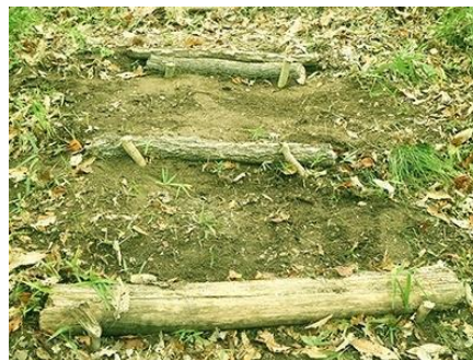
補修後の階段
