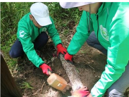
階段の補修・増設
