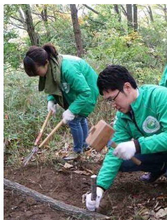
階段の補修 杭で固定
