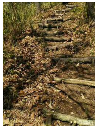
完成した階段
