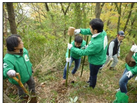
支柱を打ち込みます
