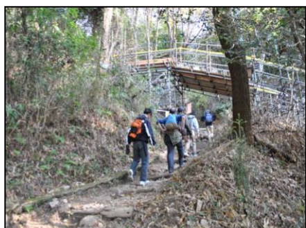
砂防工事の現場を横目に 現地に向かいます。
