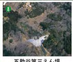
五助谷第三えん堤
