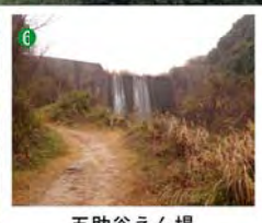
五助谷えん堤
