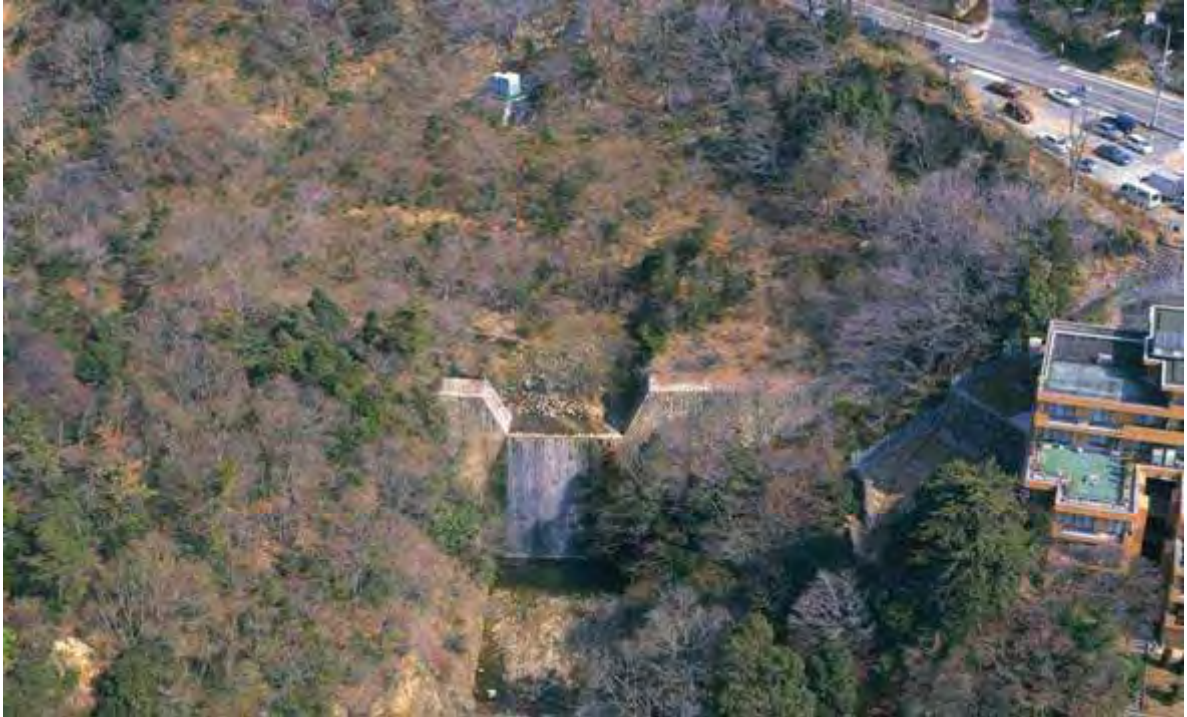
城山堰堤（昭和16年竣工）
