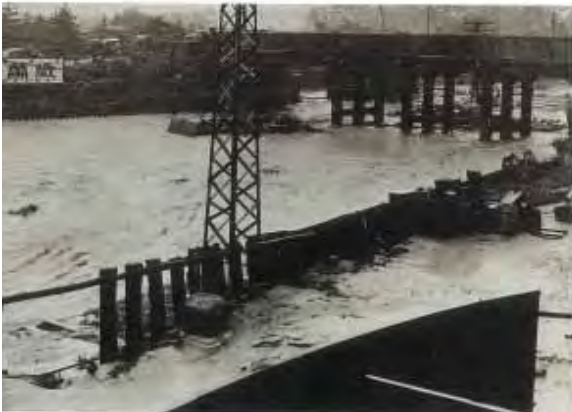
阪神大水害による芦屋市の被害状況
