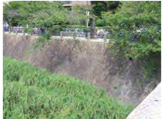
左岸（改修後の石積）
