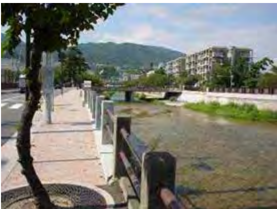
・現在の芦屋川と芦屋川トンネル
