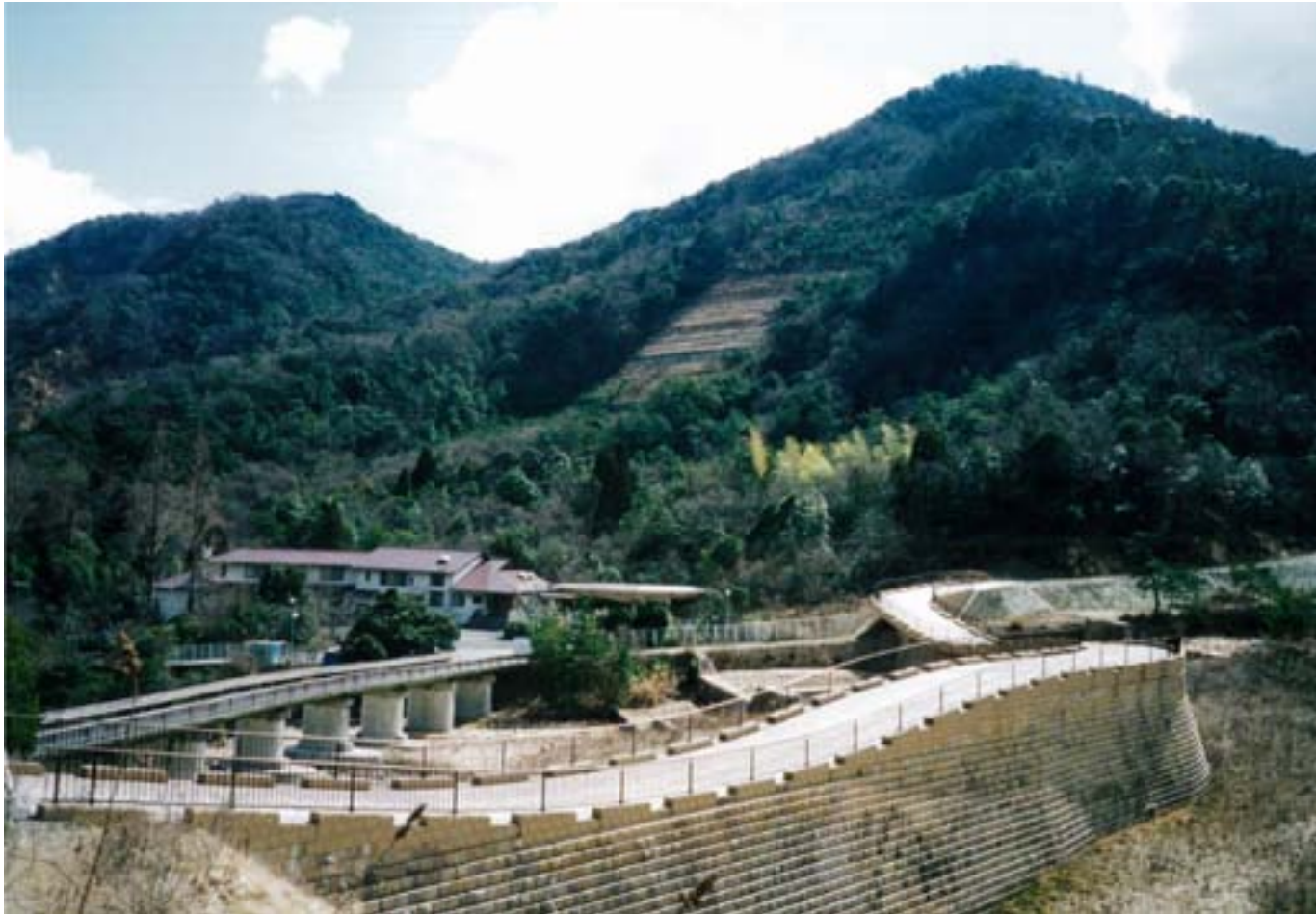
山腹工による復旧状況(2005)。
