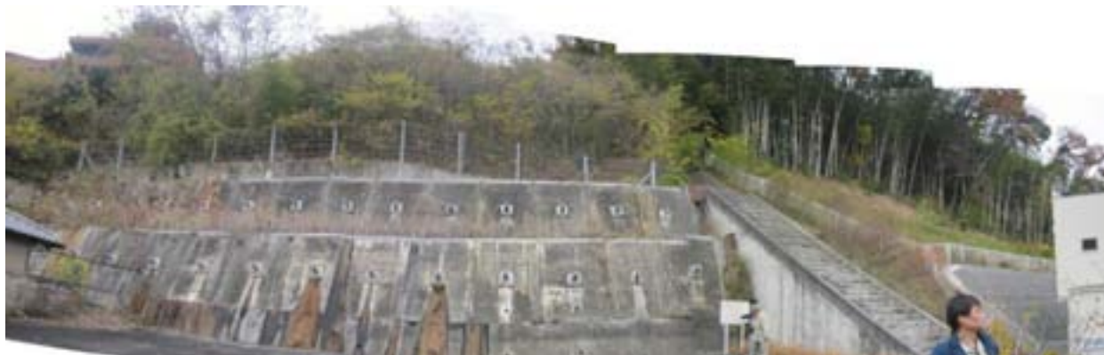
末端斜面の地すべり恒久対策状況(アンカー工)(2015.12.10)。 常時湧水あり。
