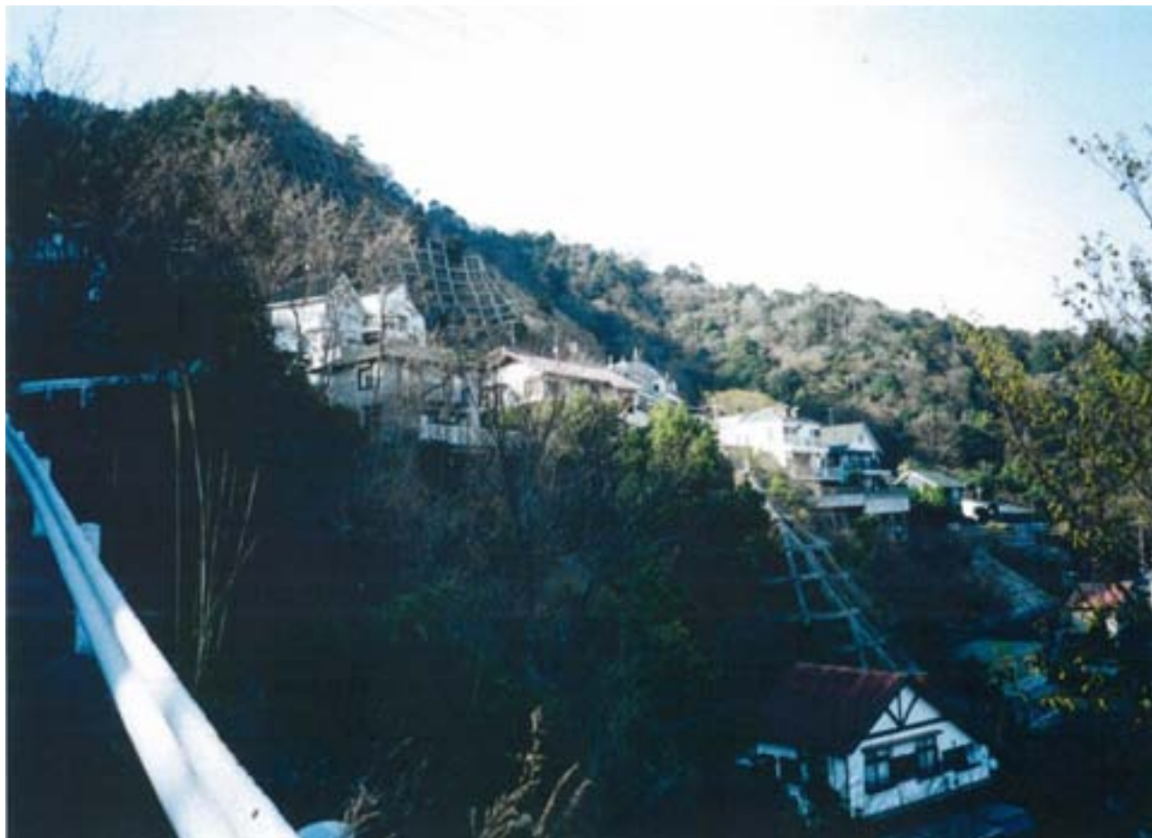
崩壊地の復旧状況(2005)。現場打法砕工+アンカー工。
