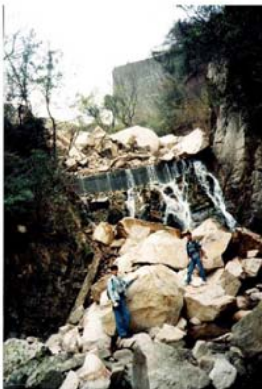
河床を崩落した「天狗の鼻」の残骸である岩塊群で埋めた状況。芦屋川河床沿いの変状。
