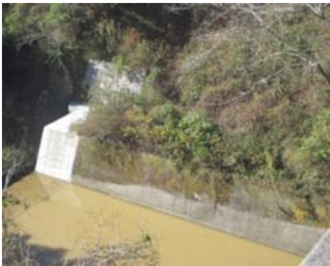
堰堤下流側の崩壊跡。植生が繁茂し、副堤が作られている(2015.12.14)。
