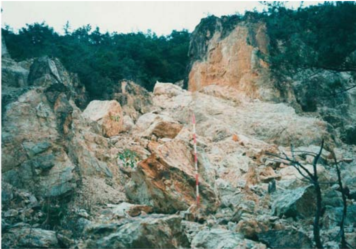
座頭谷右岸の岩盤からなる側面の岩石ナダレ崩壊(右上明るい部分)崩落岩塊群。
