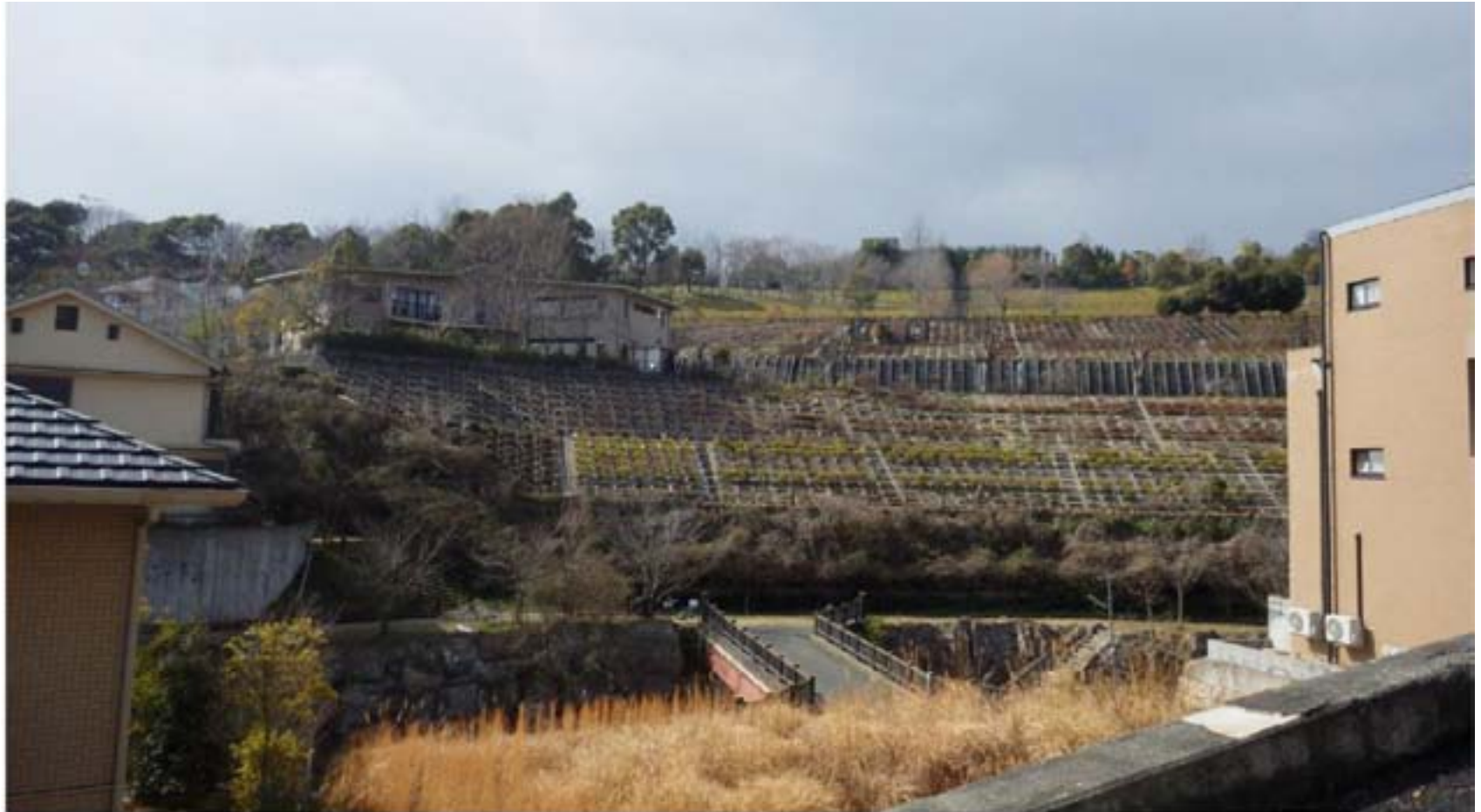
地すべり地の復旧状況 (2015.12.10)。
