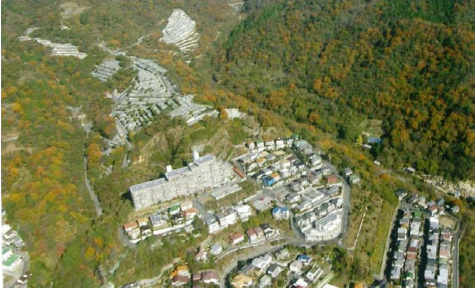
中央部崩壊地斜面上部の写真 山腹工により植生が定着(2006)。
