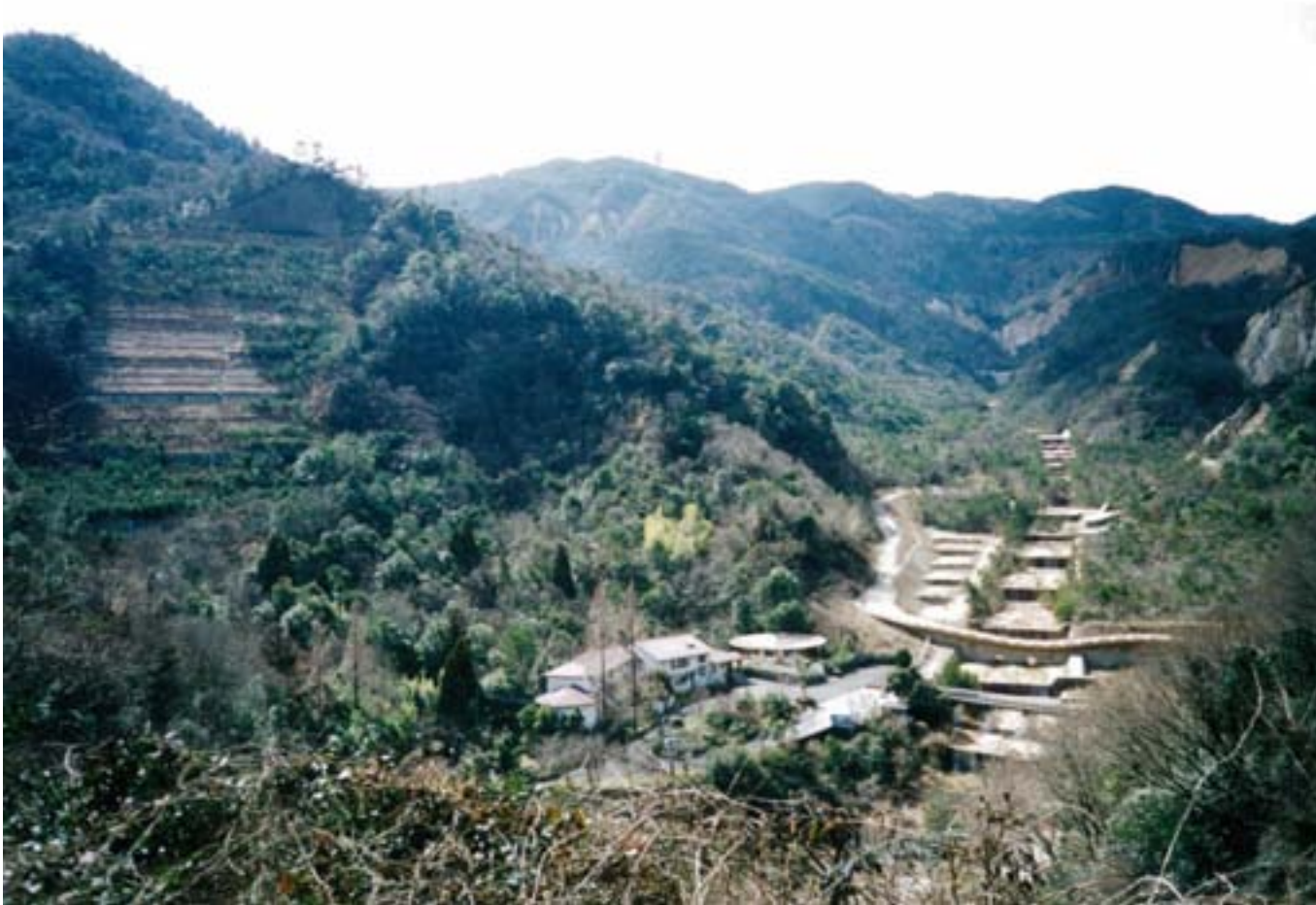
山地斜面、道路、谷部の復旧状況全景(2005)。
