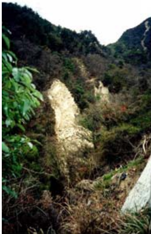
右岸の河床内に突出していた「天狗の鼻」の崩壊。
