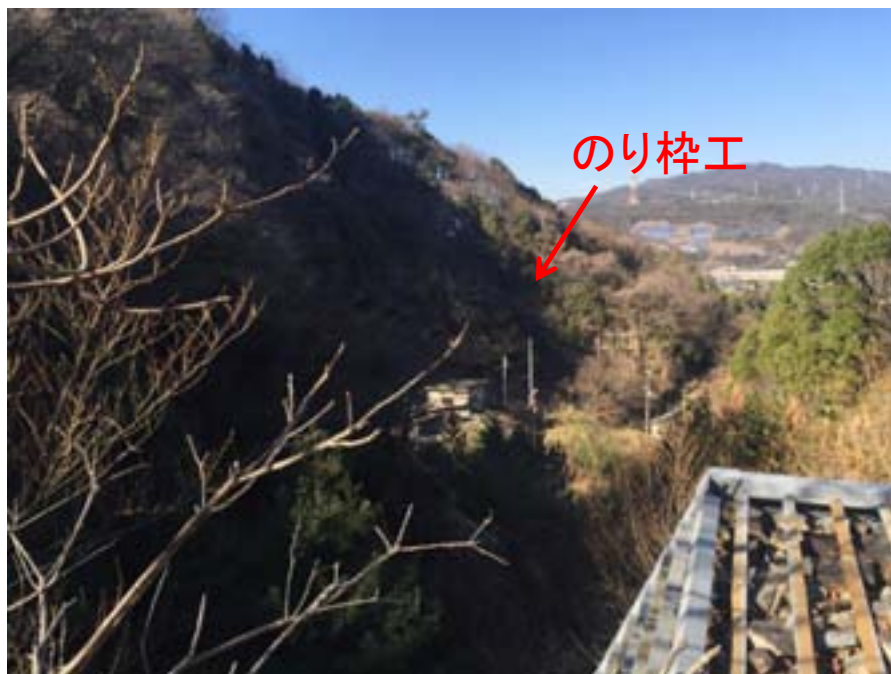
上: 崩壊箇所から下流を望む(変化なし)(2016.2.18)。
