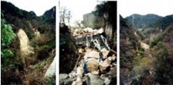
右岸の河床内に沈没していた「天狗の鼻」の崩壊
