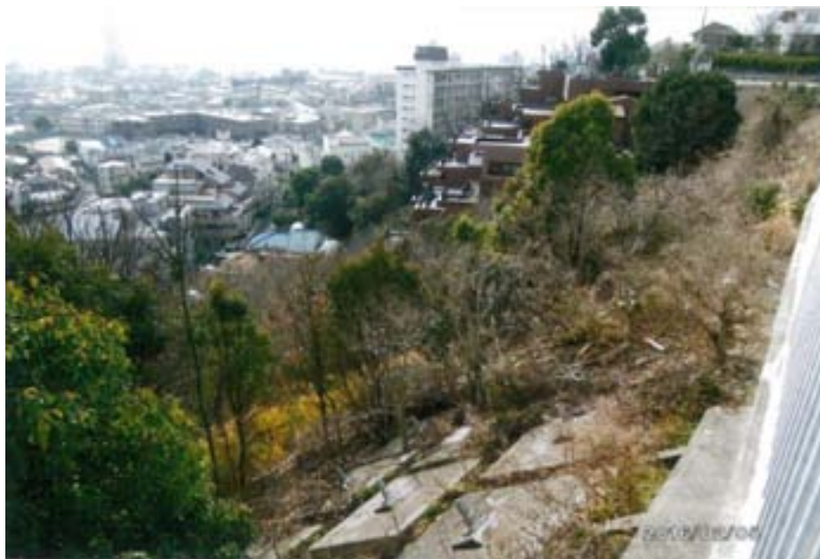
道路から神戸中心方向を望む(2016.2.5)。
