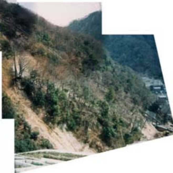
崩壊地の全景。右下に発電所。
