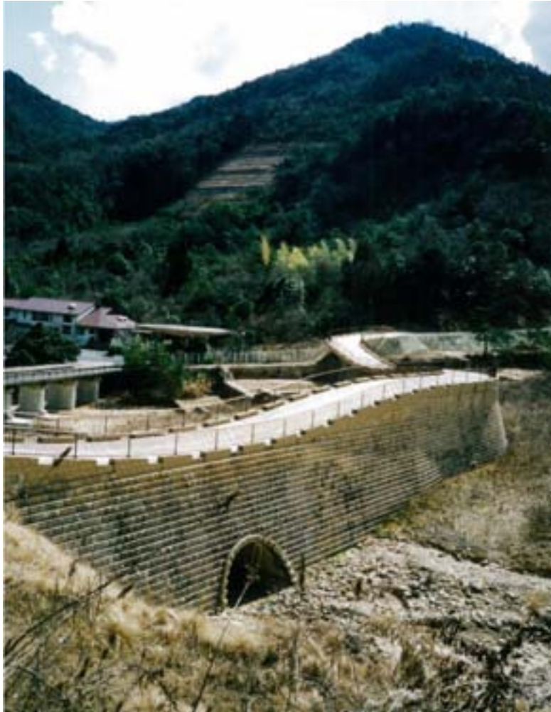
山腹工による復旧状況(2005)。
