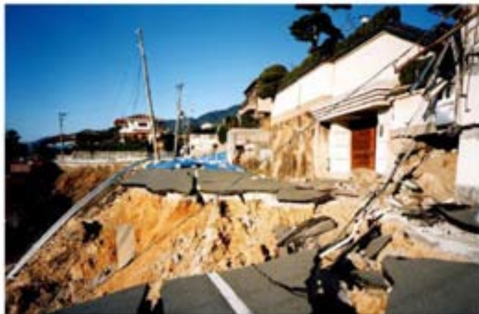
左上、崩壊地フロント。 右上、左下、盛土部分上端部のアスファルト舗装道の陥没と崩壊(図-22,図-23)。
