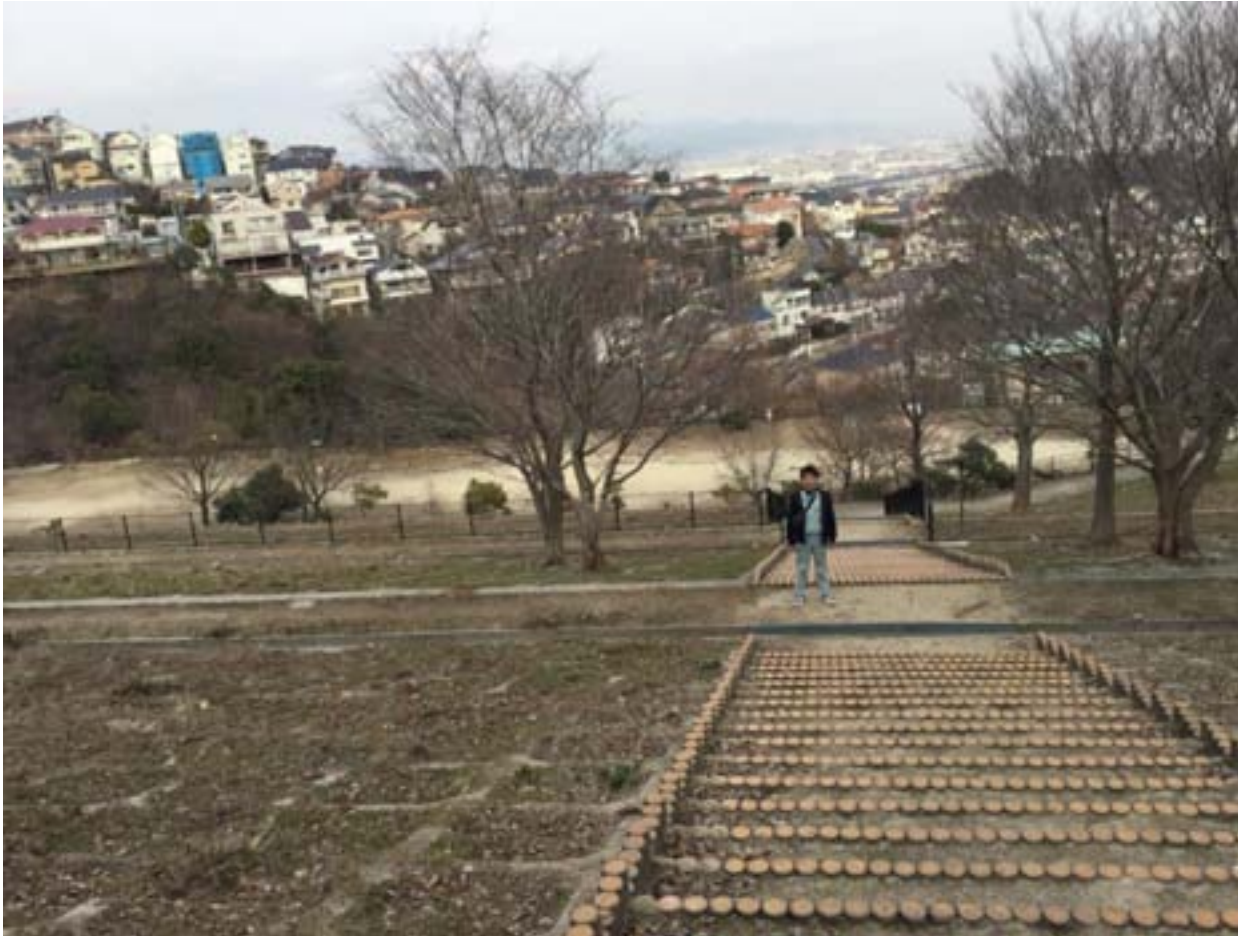
地すべり地の復旧状況(2016.2.5)。法枠で保護された法面は整備されている。
