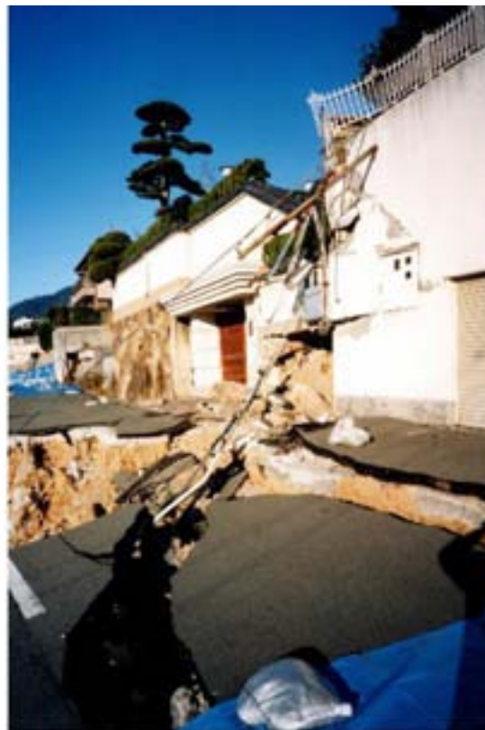
左上、崩壊地フロント。 右上、左下、盛土部分上端部のアスファルト舗装道の陥没と崩壊(図-22,図-23)。
