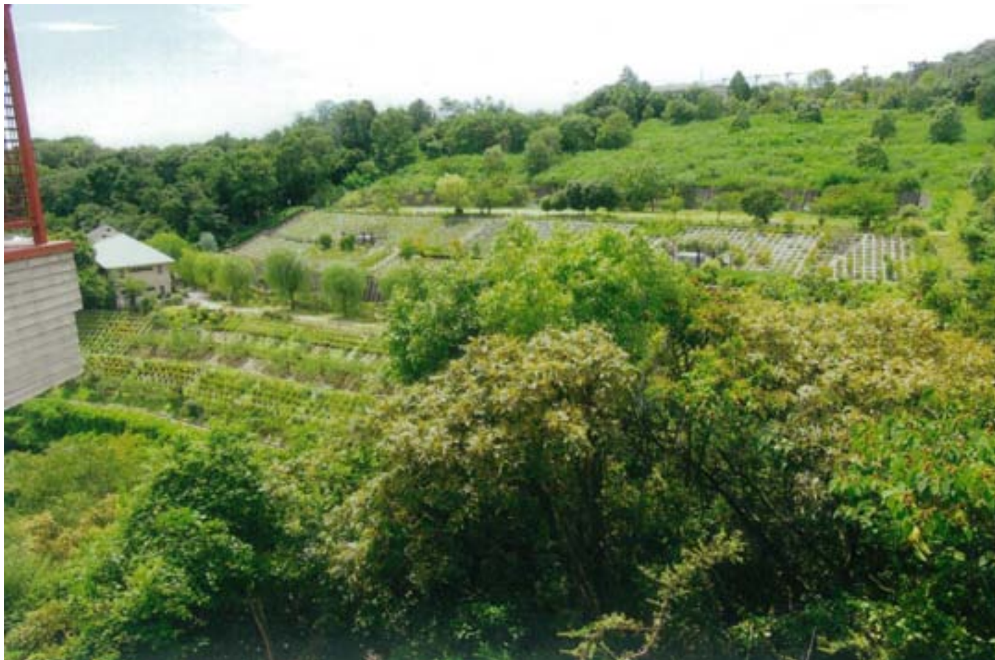
地すべり地の復旧状況 (2015.5.12)。
