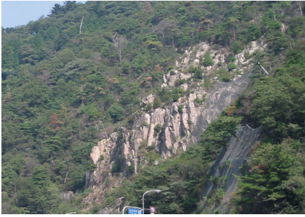
がけ崩れ等の崩壊の危険性がある箇所
