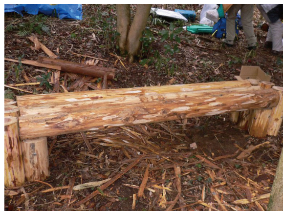
有効利用の例:ベンチの設置作業状況
