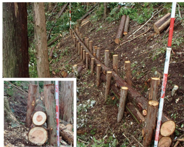
丸太筋工施工例(挟込式丸太筋工)
