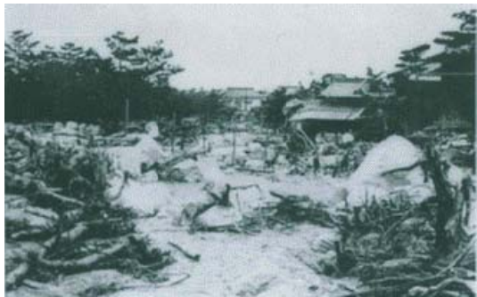
昭和13年阪神大水害時の住吉川流域の被害 (阪急線より下流側を望む)
