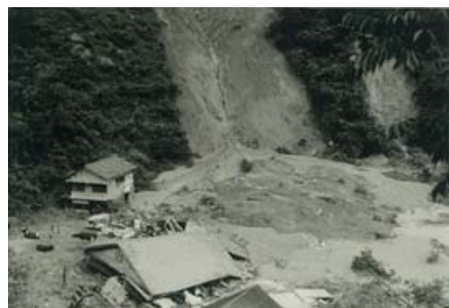
中塚さんが翌日撮影された 自宅裏の斜面崩壊
