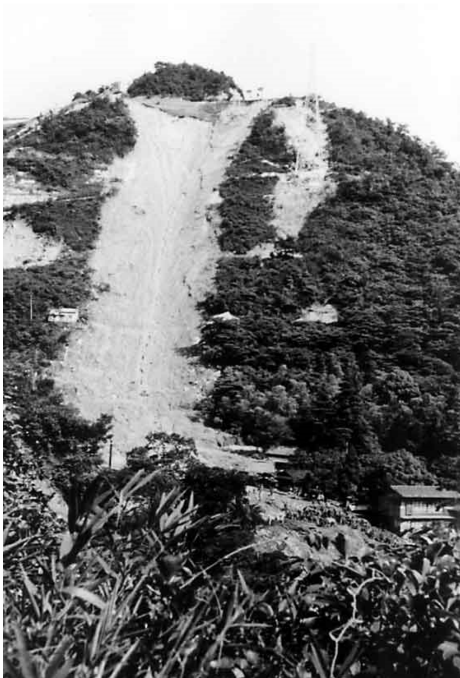
昭和42年災害で最大の被害を出した市ヶ原の大規模崩壊(神戸市中央区市ヶ原)
