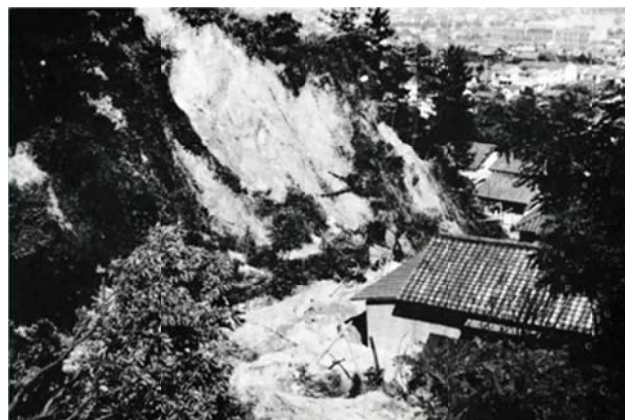
神戸市須磨区上細沢地区で発生したがけ崩れの状況
