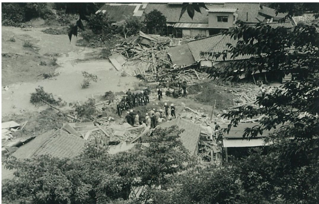
がけ崩れで埋もれた方の救出作業(神戸市長田区明泉寺)
