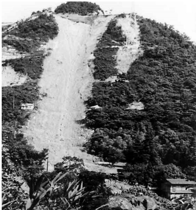
市ヶ原で発生した大規模崩壊(神戸市中央区市ヶ原)
