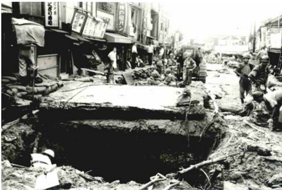
宇治川商店街の道路陥没(神戸市中央区山手通り)
