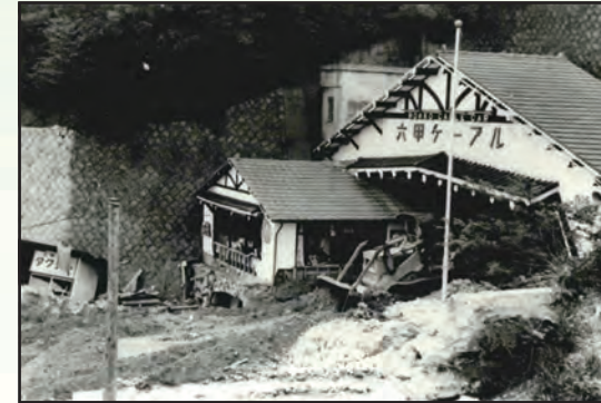
土砂に埋まった六甲ケーブル下駅
