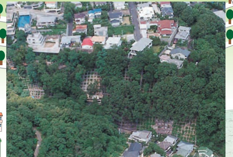
現存植生を保全した背谷山腹工
