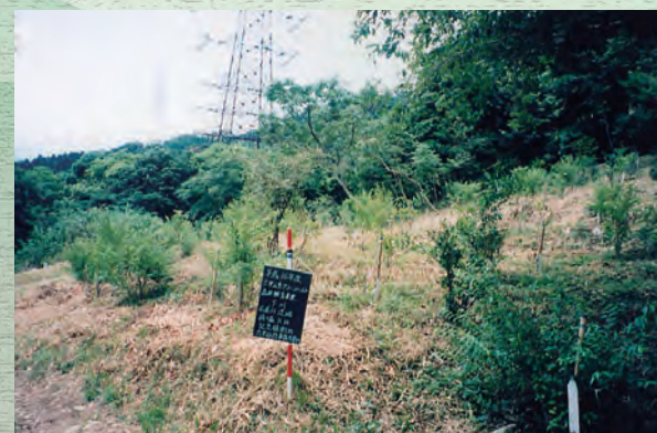
▲作業後 (石屋川流域渦ヶ森地区)
