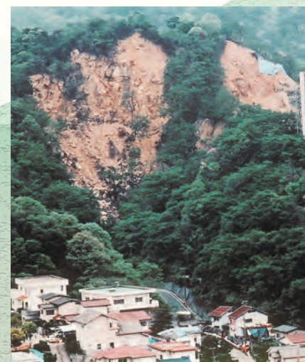
住吉台の山腹崩壊
