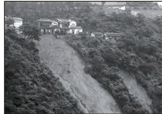
長田区明泉寺町のがけ崩れ
