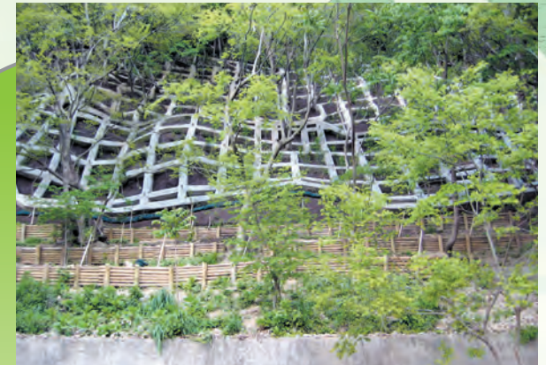
現存植生を保全した法枠工(田辺地区斜面对策)
