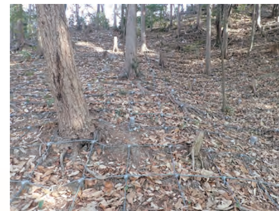
ワイヤー連結工
