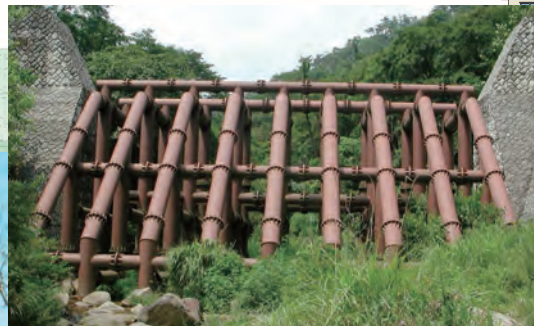
生物の遡上を阻害しない鷹尾第二堰堤
