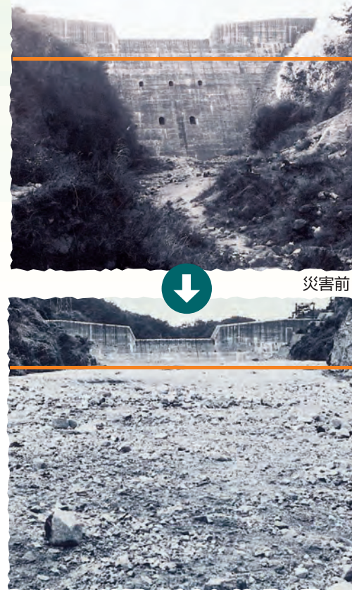
災害後(12万 m 3 の土石流を貯留)
