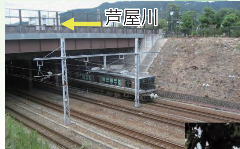
芦屋川鉄道トンネル (JR東海道本線)
