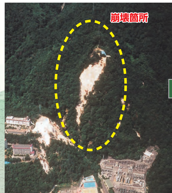
▲施工前（平成7年8月）
