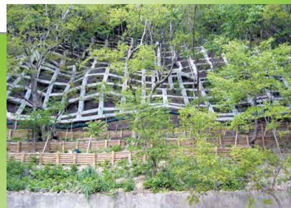
現存植生を保全した法枠工（田辺地区斜面对策）
