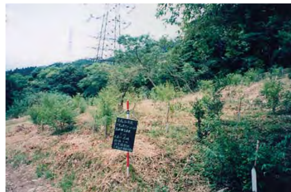
▲作業後(石屋川流域渦ヶ森地区)
