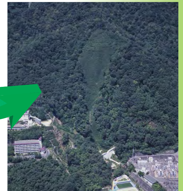
▲ 施工後（平成16年5月）
