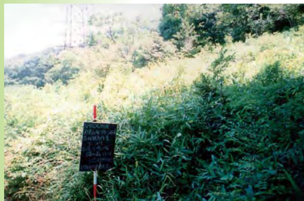
▲作業前(石屋川流域渦ヶ森地区)
