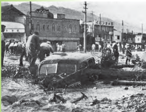
泥土に埋もれるトラック
