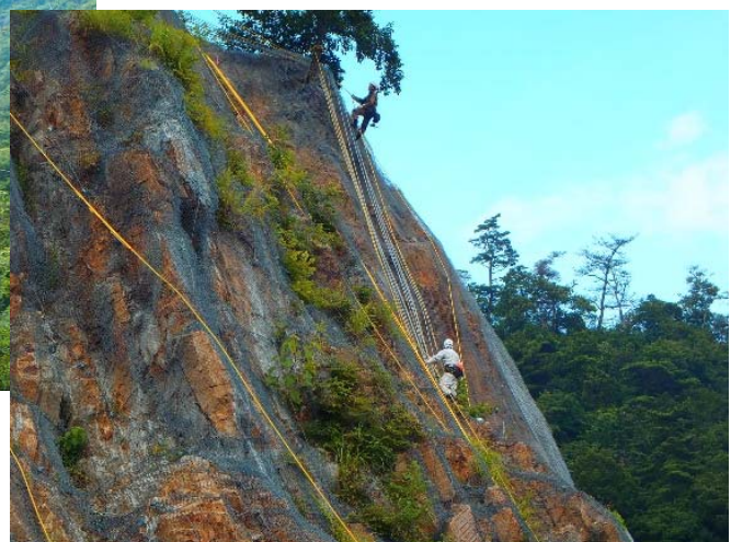
苧川谷山腹工の施工状況
