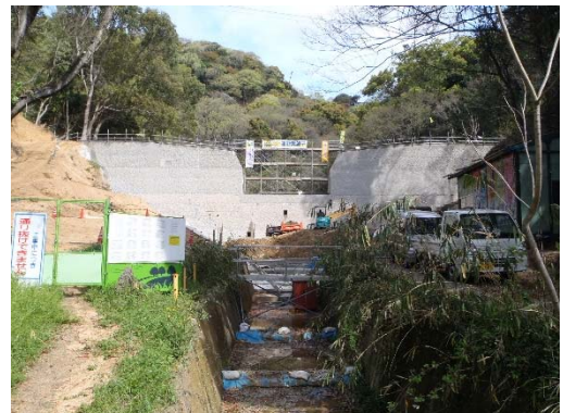
赤旗堰堤補強
