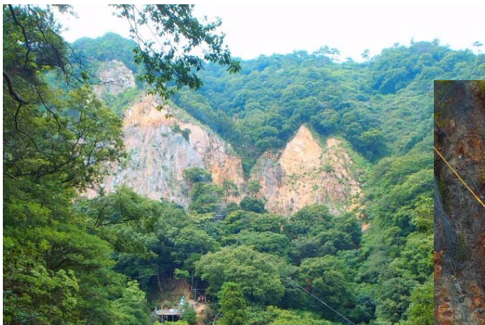
施工状況（遠景）
