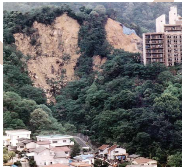
住吉台の山腹崩壊
