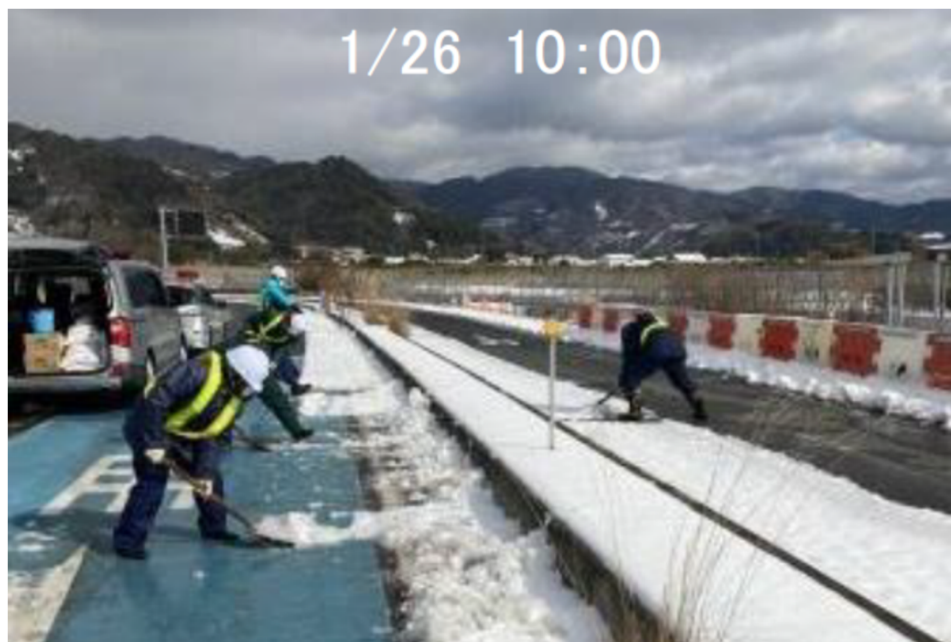
京奈和自動車道(和歌山)では、除雪で残った路肩部分の残雪を人力で実施
