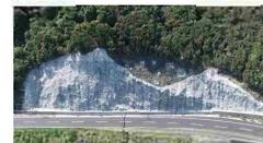
法面吹付工、落石防止網工
