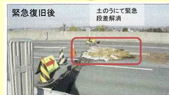
東日本大震災時の緊急復旧状況
