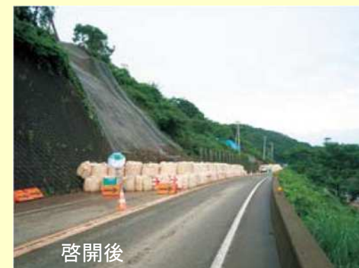
道路啓開状況（新潟県上越市長浜）
