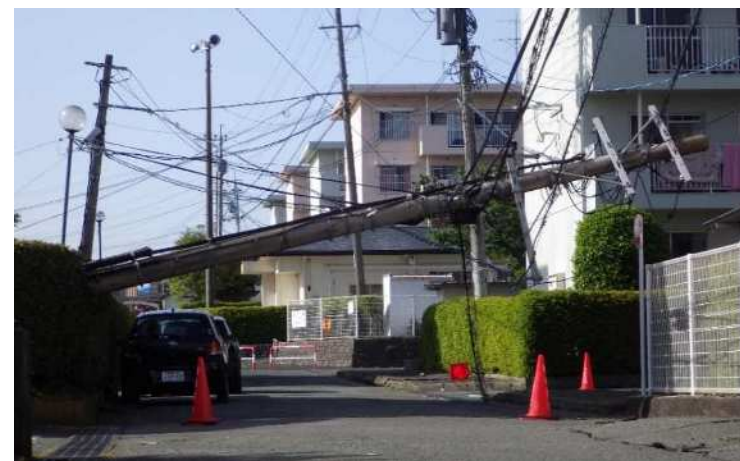
災害時における道路被害の事例
