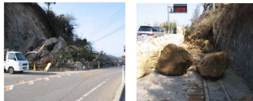
災害時における道路被害の事例
