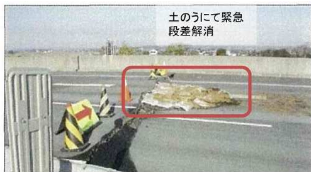
橋梁段差の解消
