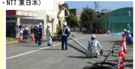
バックホウによる電柱撤去
