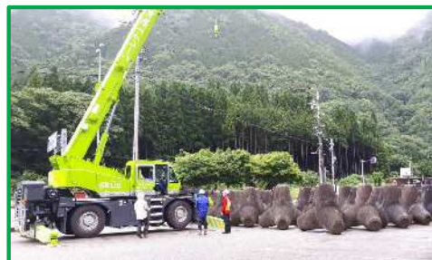
◆ 資機材の保管
