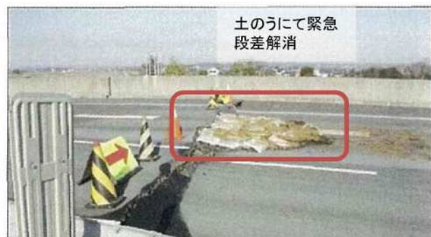
橋梁段差の解消
