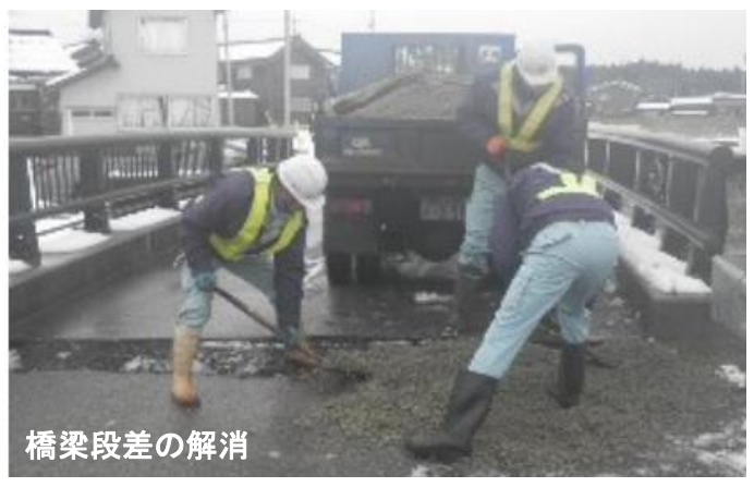
出典) 国土交通省資料 (能登半島地震の道路啓開・復旧状況)
