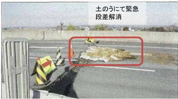
橋梁段差の解消
