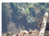
阿蘇大橋の崩落により損傷した 管路
