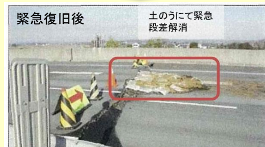
東日本大震災時の緊急復旧状況
