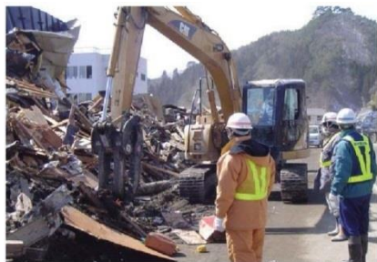
ガレキの撤去作業
