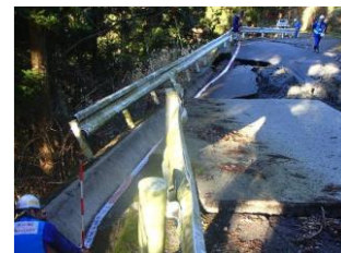
長野県北部地震における調査事例
