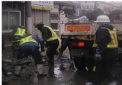
ダンプトラックによる搬出
