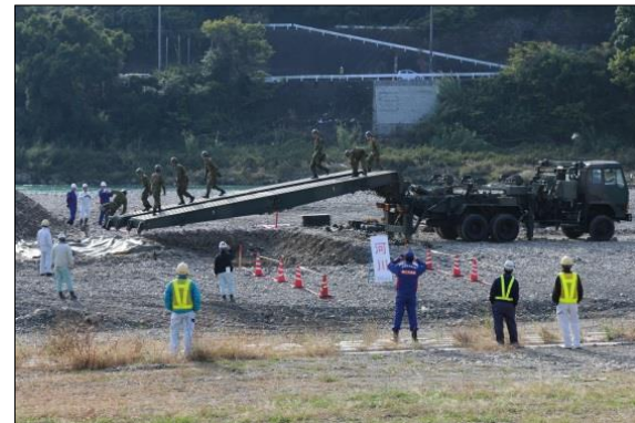
○自走式架柱橋による橋梁復旧
