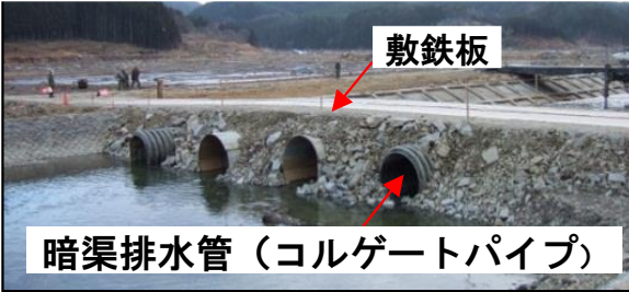
暗渠排水管等による橋梁復旧
