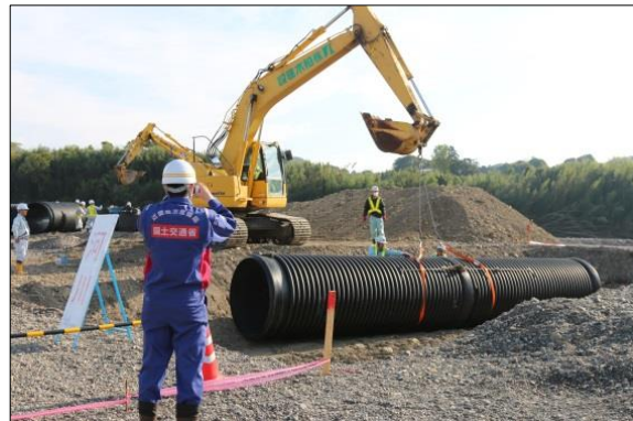
○暗渠排水管による橋梁復旧
