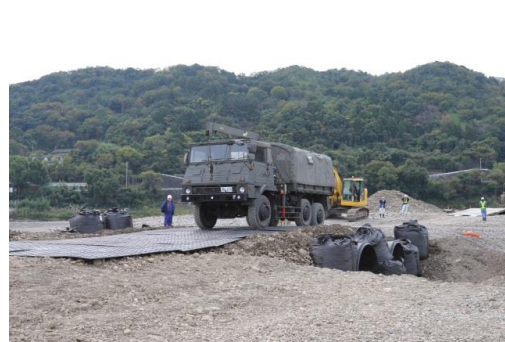
○暗渠排水管による橋梁復旧
