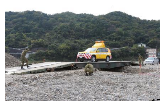
○自走式架柱橋による橋梁復旧
