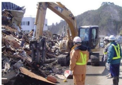
ガレキの撤去作業
