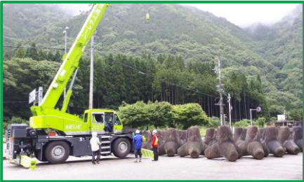
◆ 資機材の保管
