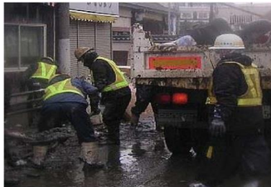
ダンプトラックによる搬出
