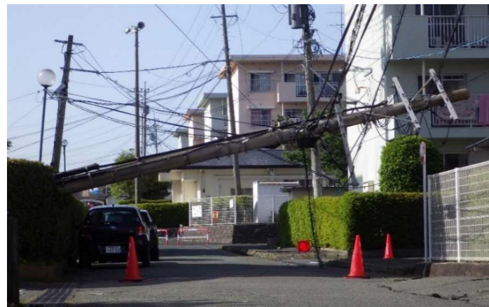
災害時における道路被害の事例
