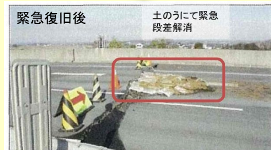
東日本大震災時の緊急復旧状況
