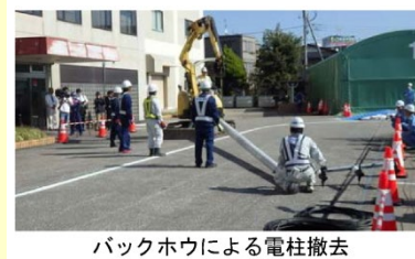
電柱撤去訓練状況
