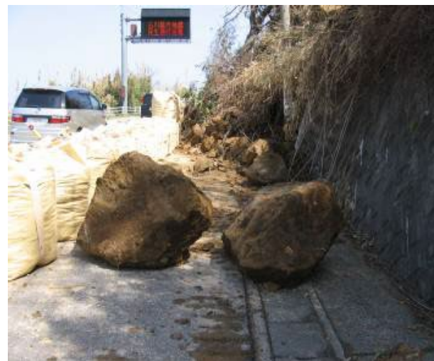
災害時における道路被害の事例
