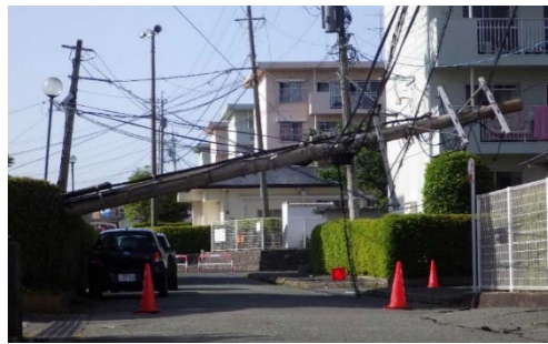
被災状況「電柱の倒壊」の写真
