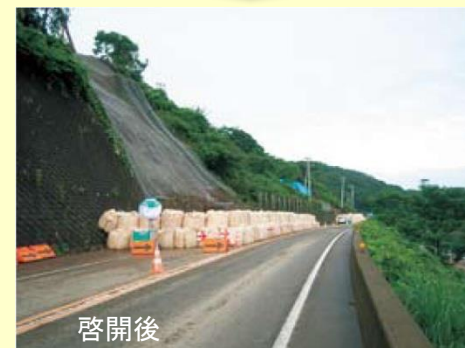
道路啓開状況（新潟県上越市長浜）
