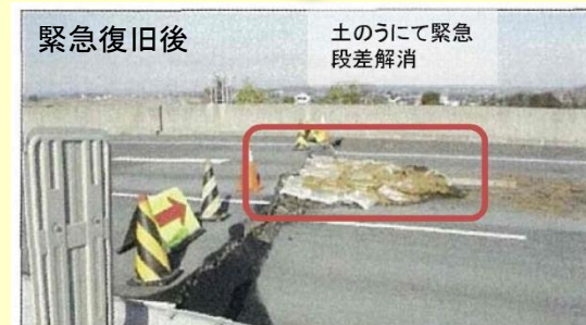
東日本大震災時の緊急復旧状況
