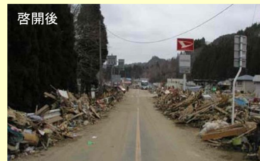
道路啓開状況（岩手県宮古市田老地区）
