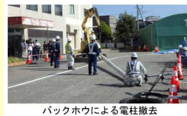
電柱撤去訓練状況
