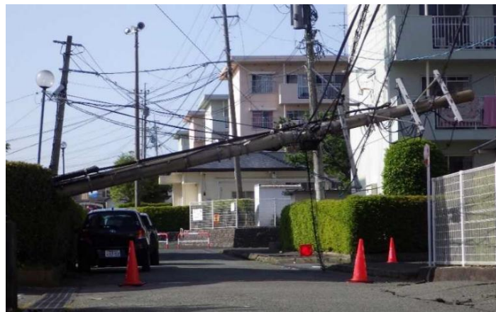
災害時における道路被害の事例
