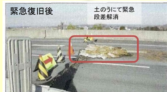
東日本大震災時の緊急復旧状況
