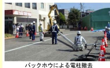
電柱撤去訓練状況
