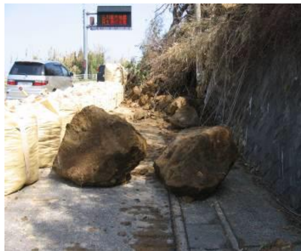
災害時における道路被害の事例
