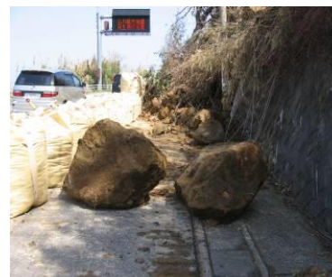
被災状況「落石」の写真
