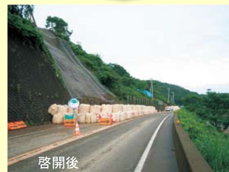
道路啓開状況（新潟県上越市長浜）
