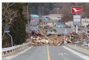
被災状況「ガレキの堆積」の写真
