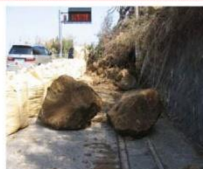
被災状況「落石」の写真
