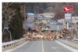
被災状況「ガレキの堆積」の写真
