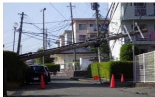
被災状況「電柱の倒壊」の写真
