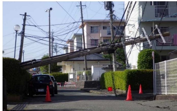
災害時における道路被害の事例
