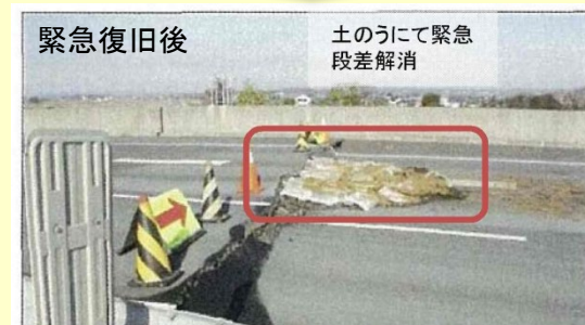
東日本大震災時の緊急復旧状況
