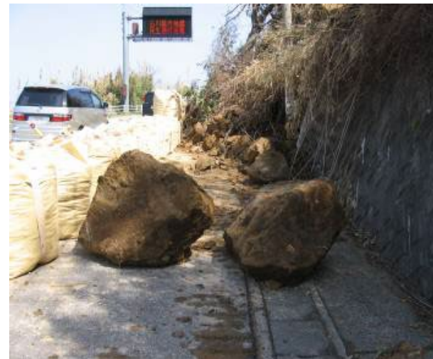
災害時における道路被害の事例
