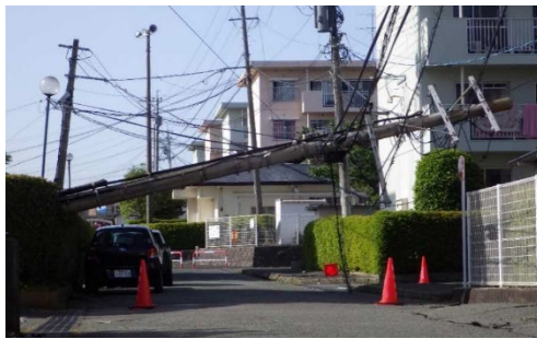
被災状況「電柱の倒壊」の写真
