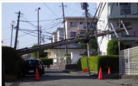
被災状況「電柱の倒壊」の写真
