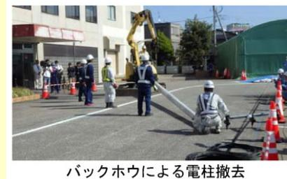
バックホウによる電柱撤去
