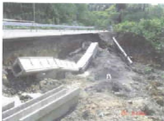
写真 3-5 盛土法面の崩壊状況（東日本大震災での被災事例）
