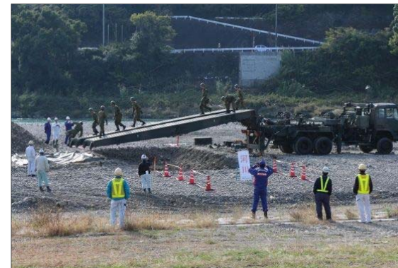
○自走式架柱橋による橋梁復旧
