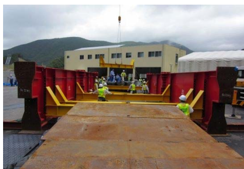
○緊急仮設橋組立訓練
