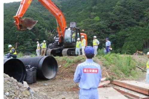
○暗渠排水管による橋梁復旧訓練
