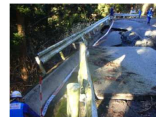
長野県北部地震における調査事例
