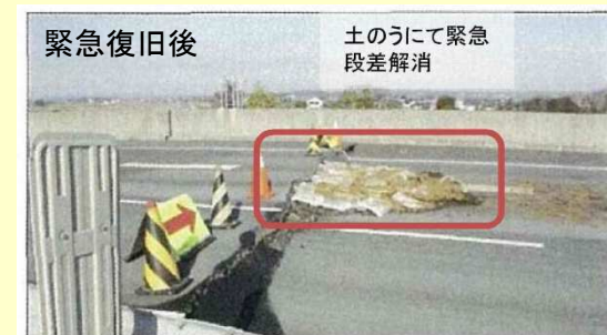
東日本大震災時の緊急復旧状況
