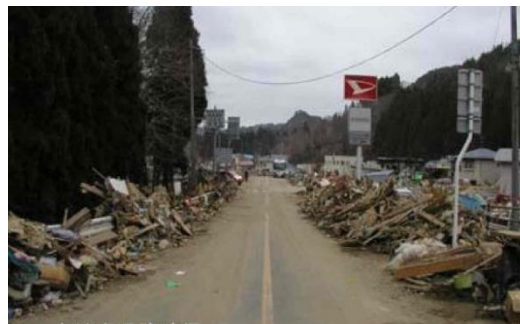
瓦礫・土砂等の除去
