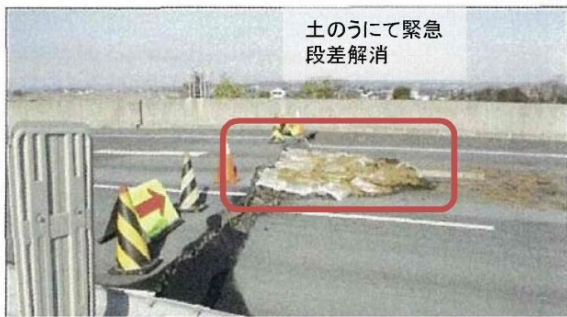
橋梁段差の解消
