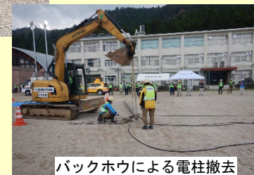
電柱撤去訓練状況 (令和6年度滋賀県地域版道路啓開訓練)
