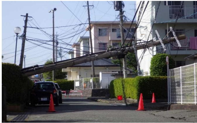
災害時における道路被害の事例
