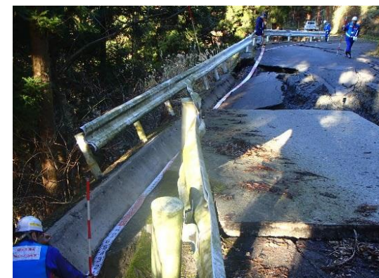
長野県北部地震における調査事例
