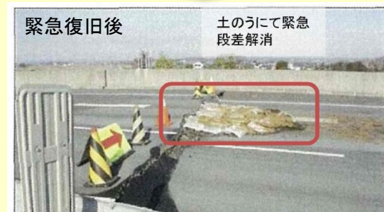
東日本大震災時の緊急復旧状況
