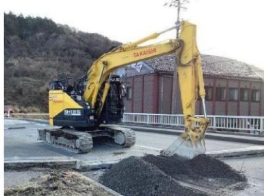
段差・亀裂箇所の道路啓開
