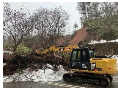
斜面崩落箇所の道路啓開
