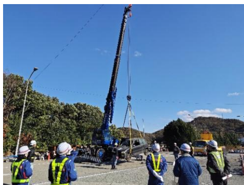
吊り下げによる車両移動
