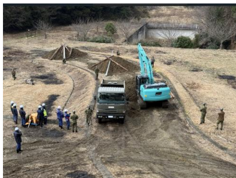
電柱倒壊の撤去訓練（自衛隊連携）
