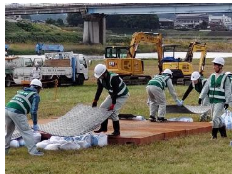
橋梁段差の解消
