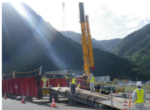
緊急仮設橋組立
