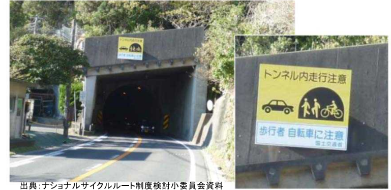
出典:ナショナルサイクルルート制度検討小委員会資料 図 千葉県での取組状況(千葉県銚南町(国道127号))
