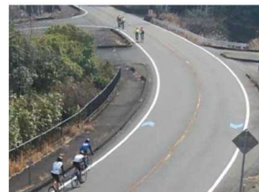
出典: ナショナルサイクルート制度検討小委員会資料 図 三重県熊野市での矢羽根の整備事例
