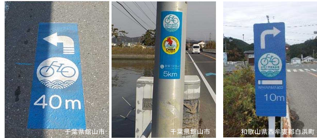
図 太平洋岸自転車道における路面表示・案内看板の設置事例
