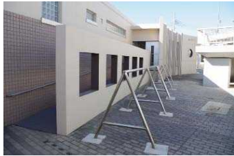
図 サイクルラック設置状況
