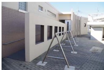
図 サイクルラック設置状況
