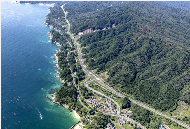
三陸沿岸道路（岩手県山田町）
