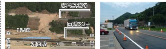
広島呉道路・国道31号の被害状況
