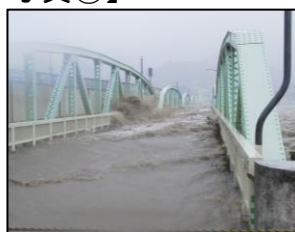
【写真①】熊野大橋の越水状況 (H23.9月 台風12号)
