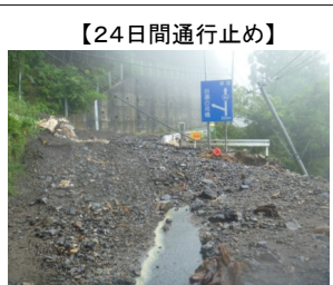
【写真①】 国道168号崩落状況(H23.9)
