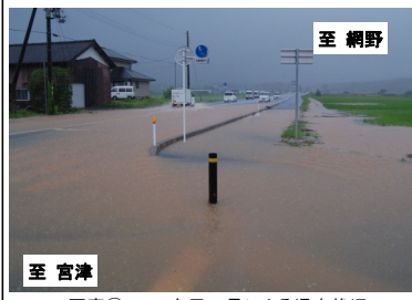
写真③ H16台風23号による浸水状況
