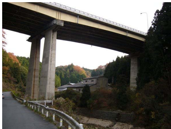
山添橋[一般国道25号名阪国道] (奈良県山辺郡)
