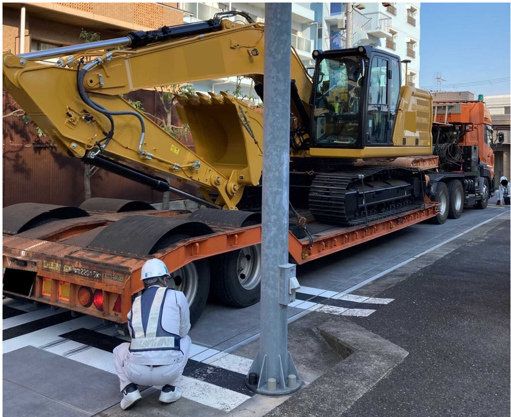
【国道43号 兵庫県西宮市】
