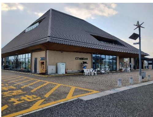
（道の駅「レスティ唐古・鍵」外観）
