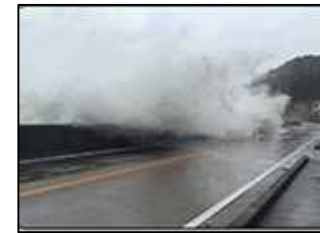
台風による越波状況 (すさみ町江住地先)
