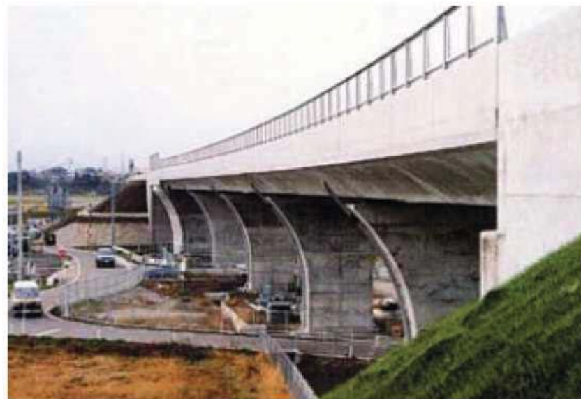
コンクリート構造(一般国道7号 秋田県大館市)
